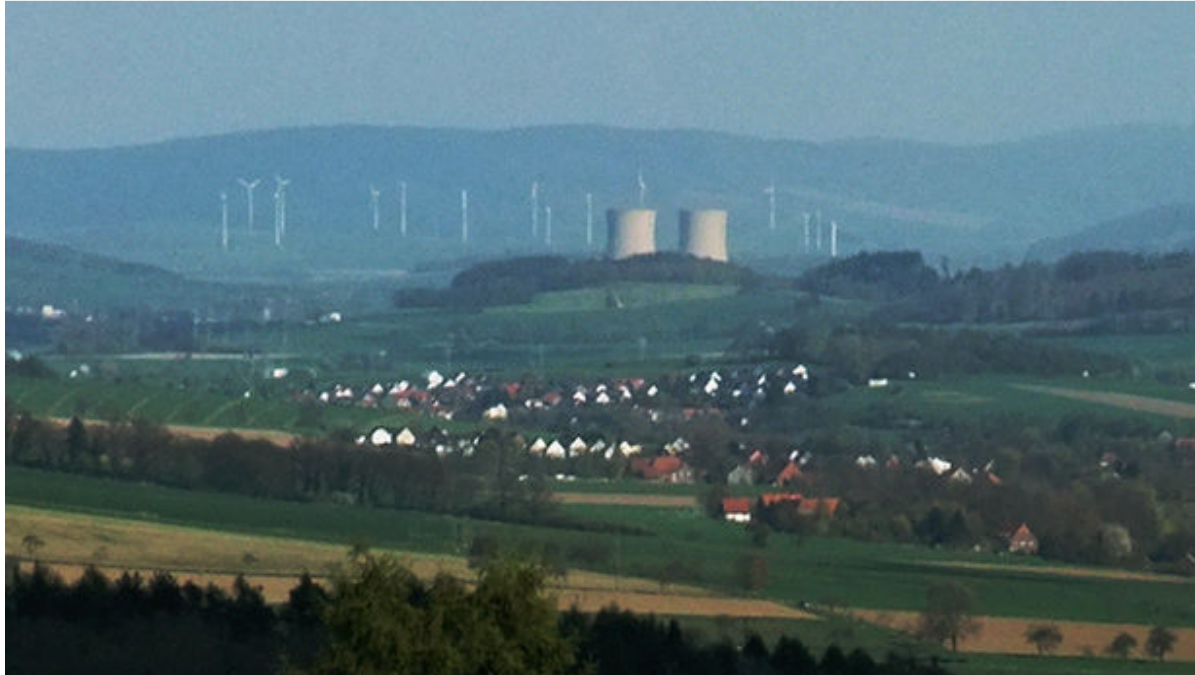
KKW Grohnde bei Wartungsarbeiten (Kühltürme ohne Wasserdampf); 14 Windradgeneratoren liefern Strom, im Hintergrund
